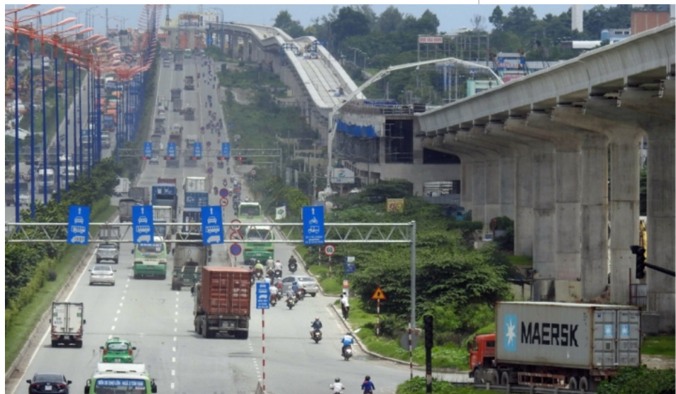
Mặc dù tuyến Bến Thành - Suối Tiên tại TP. HCM bị chậm trễ so với kế hoạch, quá trình thi công đã không xảy ra tai nạn. Ảnh: SCMP
